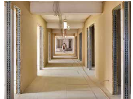
Lehm-Dünnlagen Beschichtung beim BV UN-Campus, Bonn
